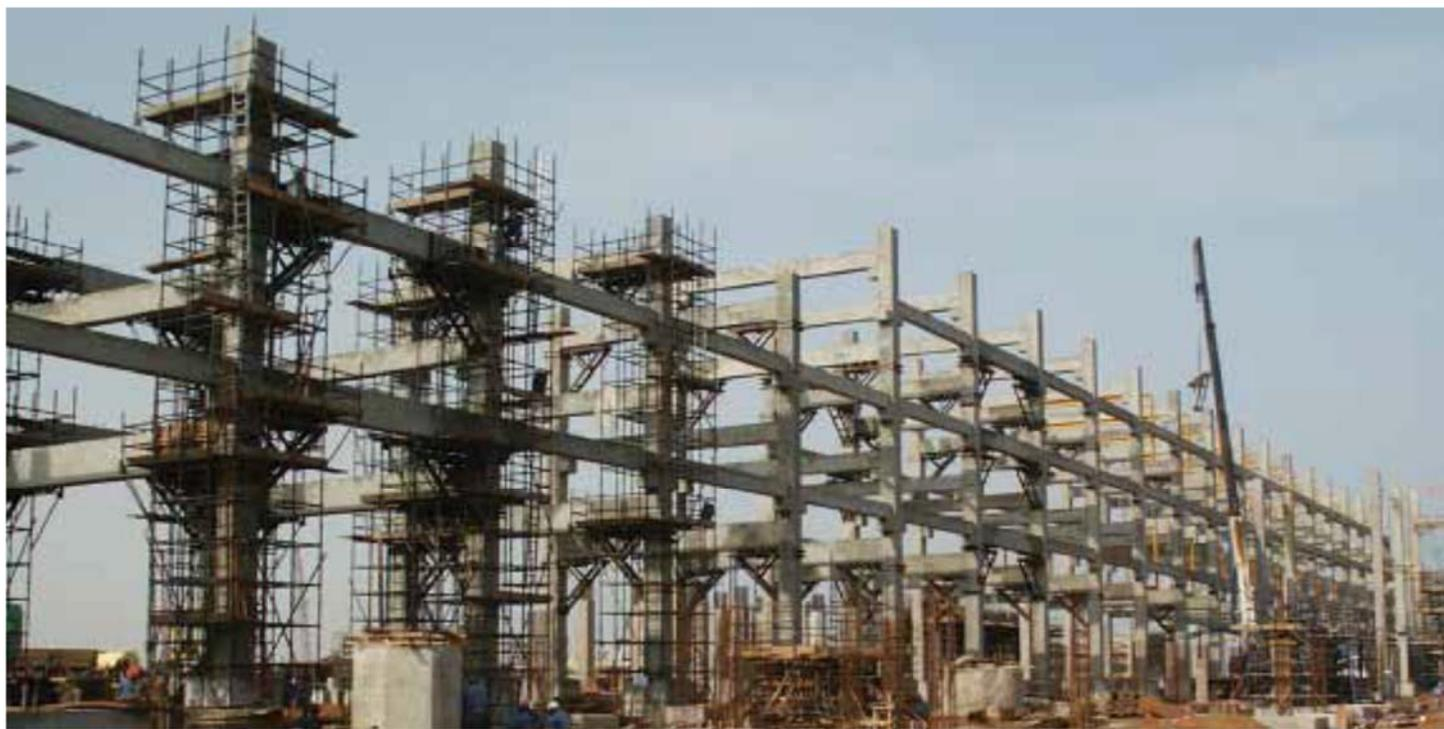
**SUPPORT DE TUYAUTERIE PRÉ-COULÉ, FONDATIONS D'ÉQUIPEMENT CRITIQUE, TUYAUTERIE SOUTERRAINE USINE DE GNL DE BALHAF (TRAIN -1 et TRAIN-2), YÉMEN LNG; YÉMEN, 2007-2010**
